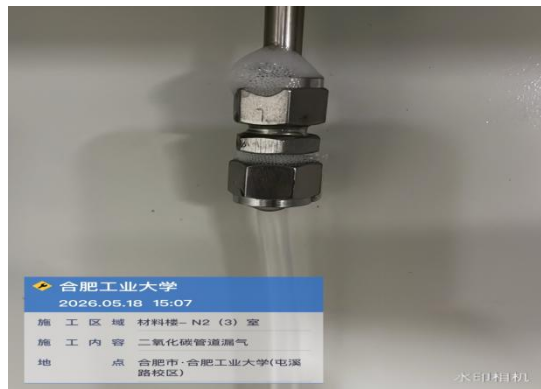
氮气管道漏气
