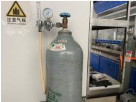
钢气瓶状态牌缺失
