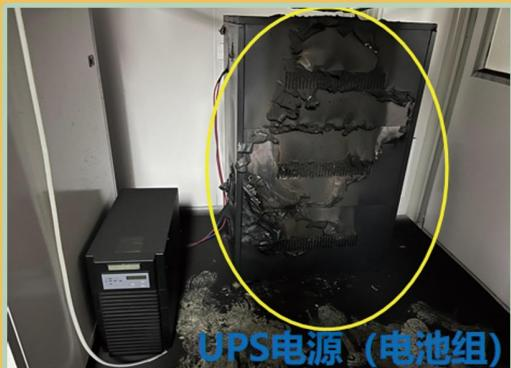
**事故原因:**实验室一台分子束外延薄膜沉积系统分子泵需24小时不间断运行，实验室配备了UPS供电。该UPS为2016年购置，电池鼓包漏液，没有及时维护保养和检修，长时间运行造成电池过热发生燃烧。
