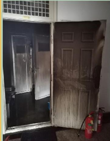
**事故原因:**实验室通风装置及通风橱在无人值守、密闭环境、高温潮湿的情况下长期通电排风，造成电线短路、电器燃烧。
