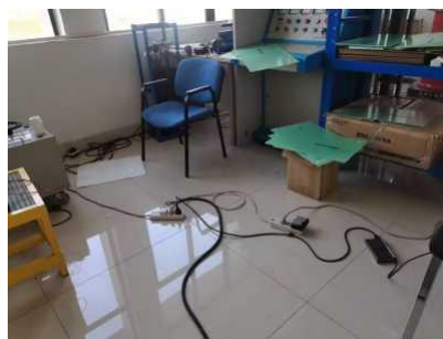
插线板串接且置于地面
