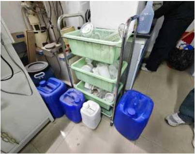
危废暂存区无警示线，未张贴标识，废液桶下面无防渗漏托盘，废液桶未张贴废液标签
