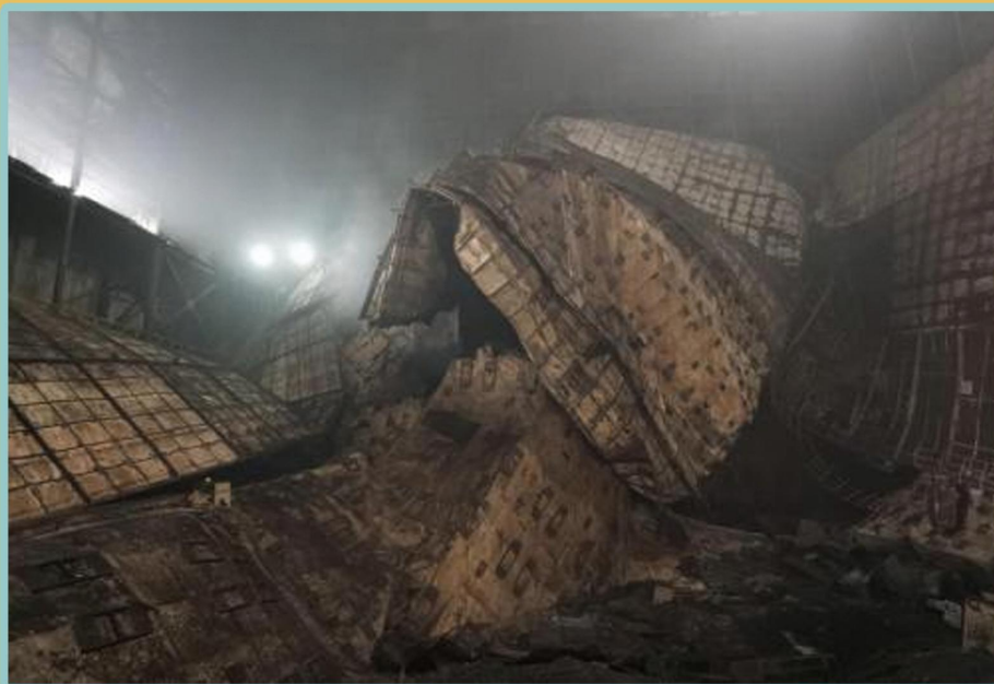
暗室屏蔽钢结构坍塌现场
